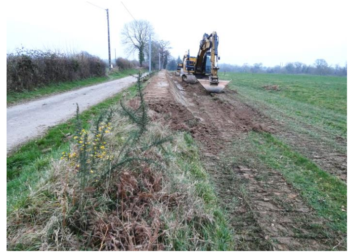
Restauration de talus
