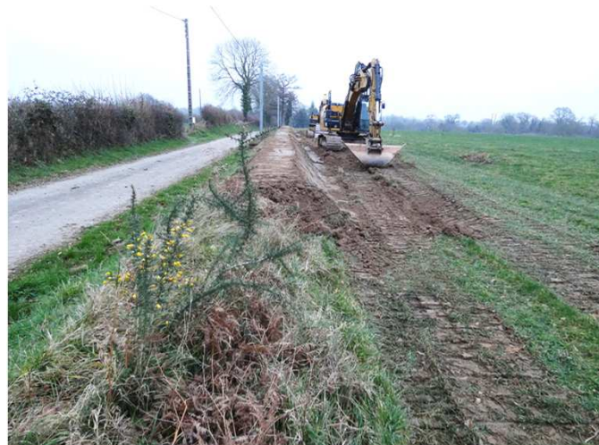
Restauration de talus
